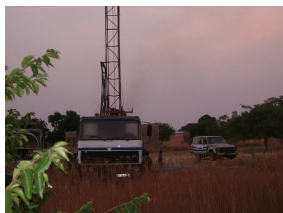
Travaux du forage
