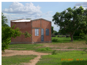
Le local pharmaceutique est achevé
